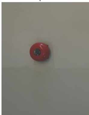
กริ่งเตือนเพลิงไหม้
