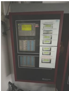
แผงควบคุมระบบสัญญาณแจ้ง เหตุเพลิงไหม้
